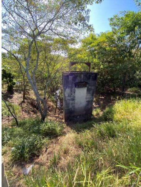
Figura 8-2– Estrutura de concreto para colocação da comporta de acionamento manual.
